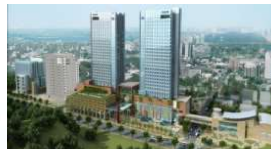
南港車站及開發大樓
